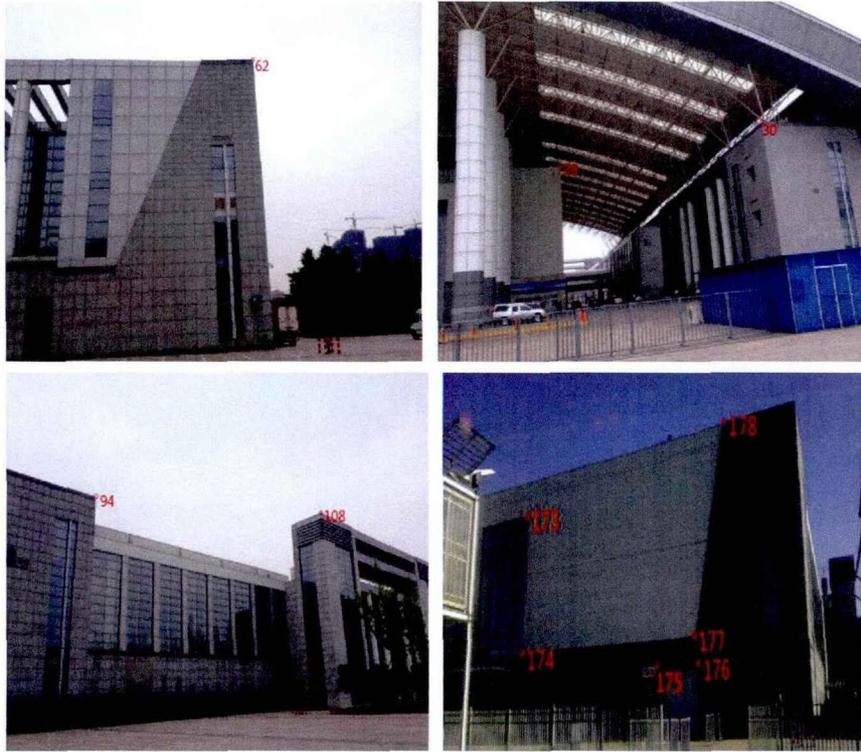
图 6.8 VZ-400 扫描仪标定所用控制点的点位分布图
